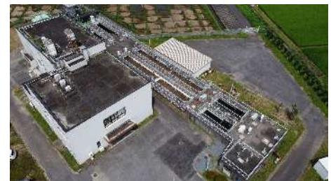
環境浄化センター
