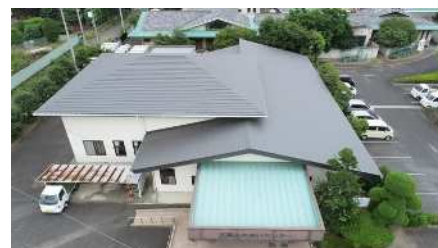
ふれあいセンター屋根改修工事
