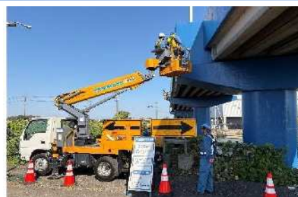
橋梁定期点検の様子(冬木橋)
