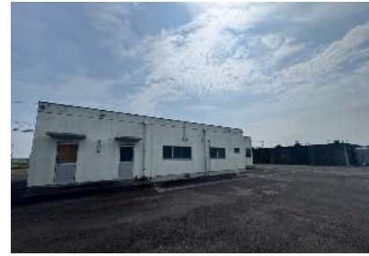
小手指配水場
