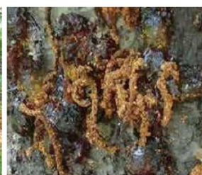
木内部から押し 出されたフラス
