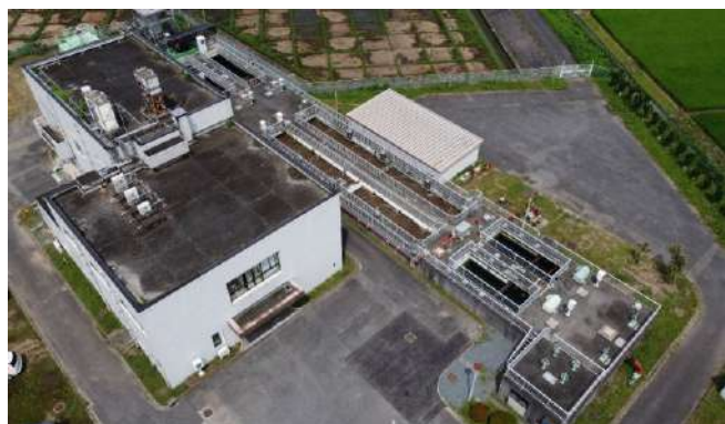
五霞町環境浄化センター
