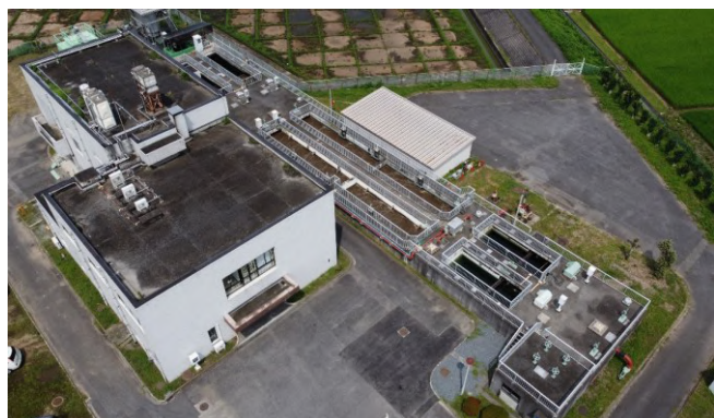
五霞町環境浄化センター
