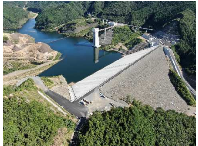
南摩ダム (試験湛水中)
