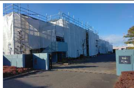
特養において大規模改修事業を実施
