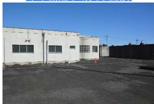
小手指配水場受水施設
