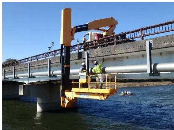
橋梁定期点検の様子(舟渡橋)
