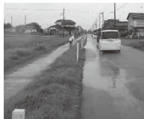
町道1914号（元栗橋地内）の水たまり
