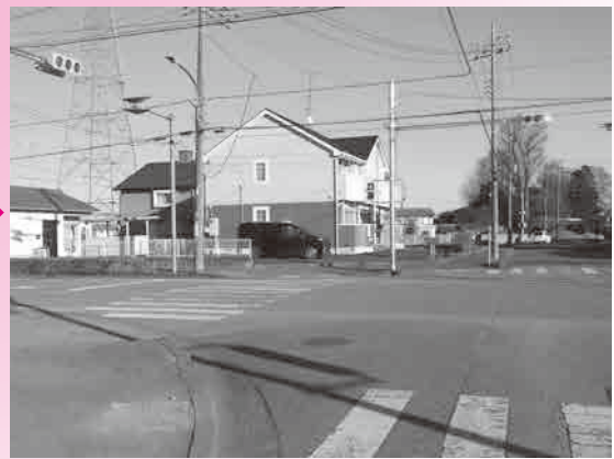
信号機設置後
