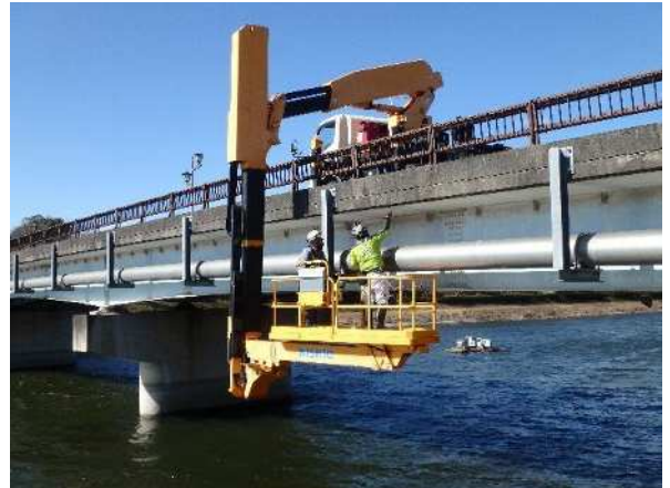
橋梁定期点検の様子(舟渡橋)
