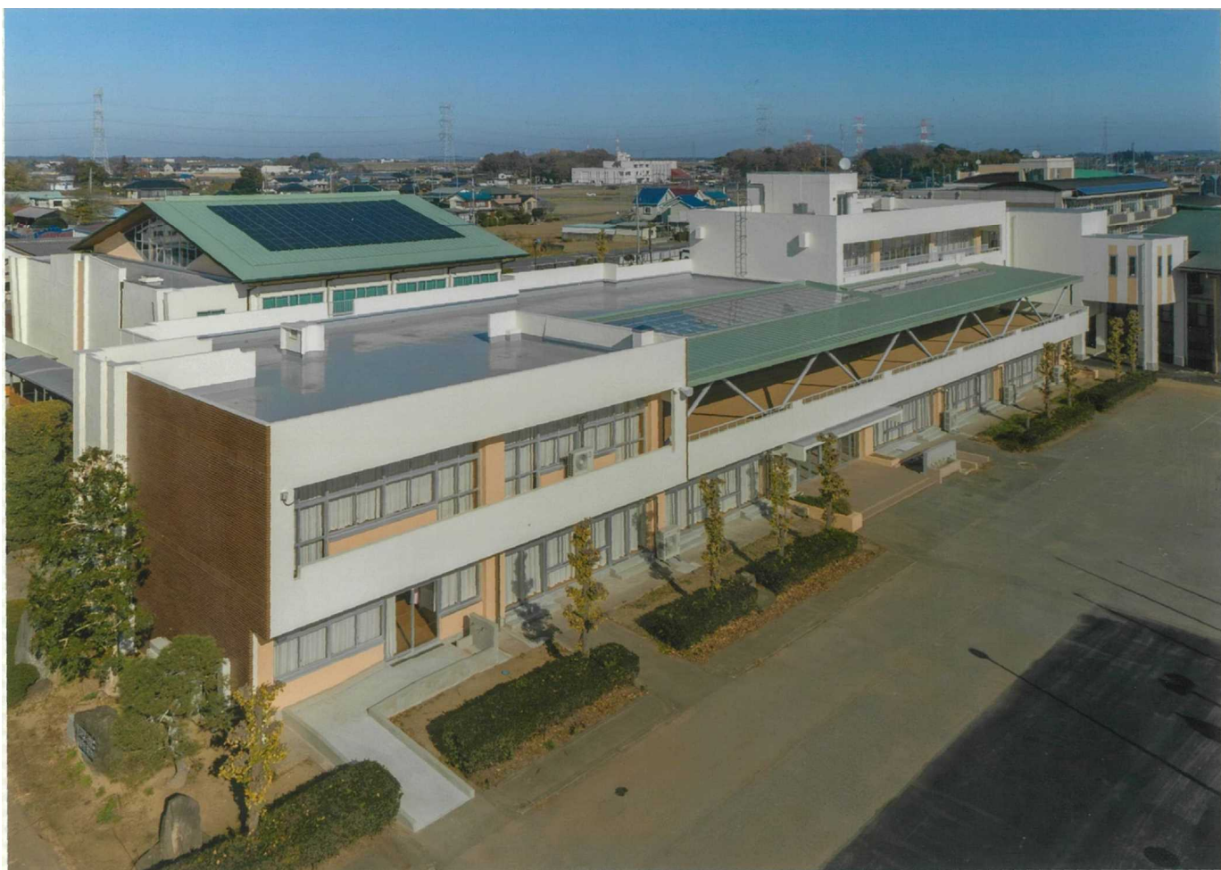
改修後の校舎外観
