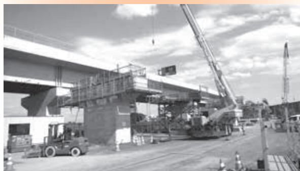
圏央道4車線化工事現場
