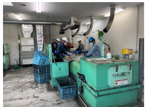
ペットボトルの再資源化(手選別) (さしまクリーンセンター寺久リサイクルプラザ内)
