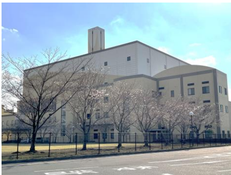
ごみ処理施設(さしまクリーンセンター寺久)
