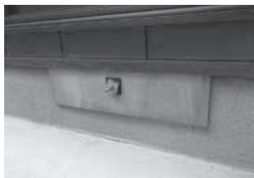
水害時床下への泥水侵入防止策 通気口遮蔽板設置前
