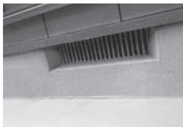
水害時床下への泥水侵入防止策 通気口遮蔽板設置前
