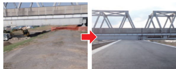
施工前 嵩上げ及び天端舗装完了後
