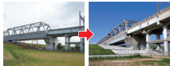
施工前 川裏（町内側）腹付け盛土完了後
