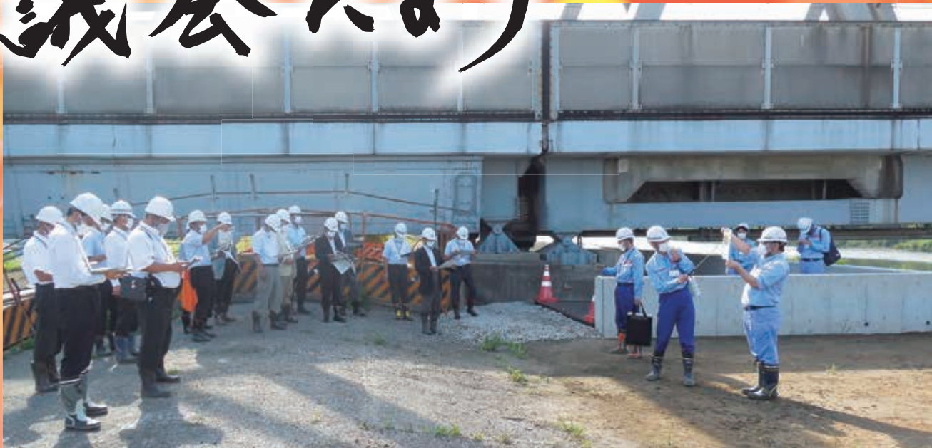
JR 新幹線下堤防工事現場視察
