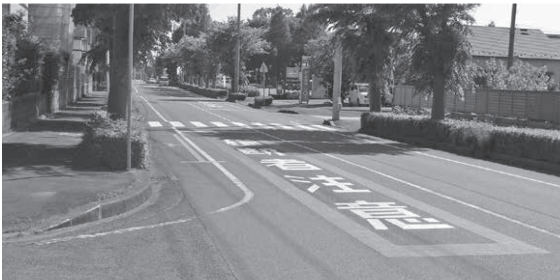
横断者注意路面標示（原宿台地内）
