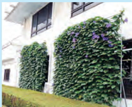
役場に設置したグリーンカーテン
