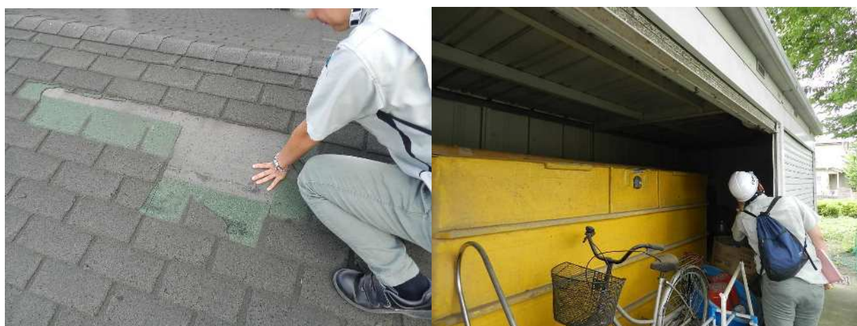
図 3 劣化状況調査の様子
