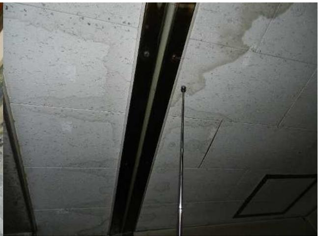
写真 14 接続部周りの天井雨漏り跡
