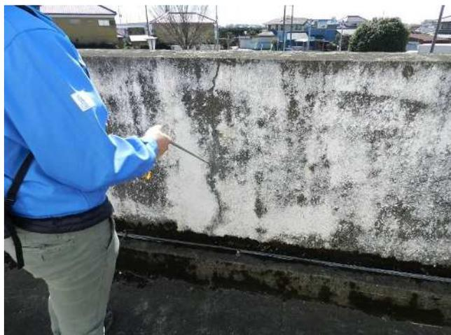
写真 1 外部立上り壁の縦クラック
