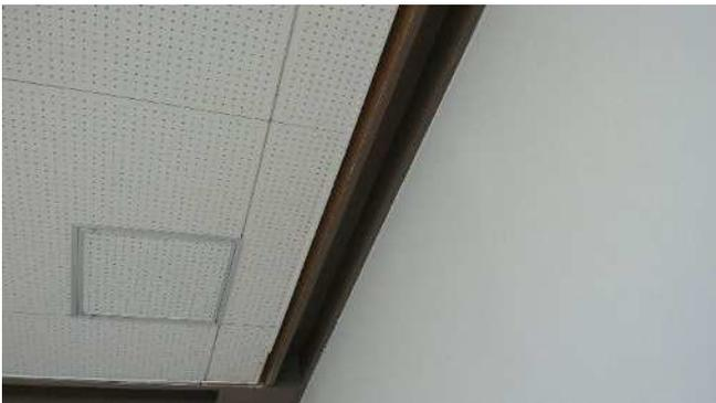
写真 21 天井ボードのゆがみ
