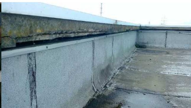
写真 16 パラペット立上りモルタル剥離
