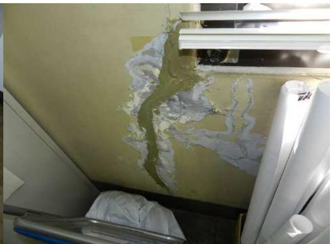
写真 10 内壁開口部の補修跡と仕上材劣化
