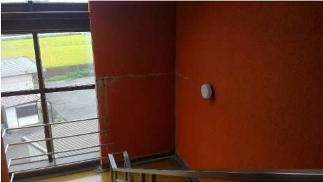
写真 19 階段踊り場に水平ひび割れ
