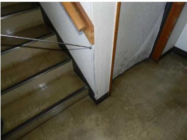
写真 9 クロス材の剥離・腐食
