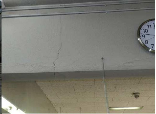
写真 6 内部梁の曲げひび割れ
