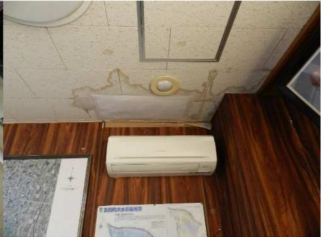
写真 12 天井雨漏り跡
