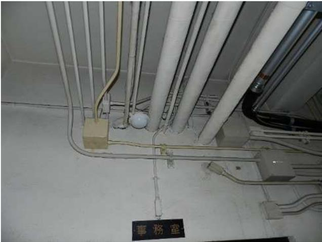
写真 5 躯体への後施工配管過密状況
