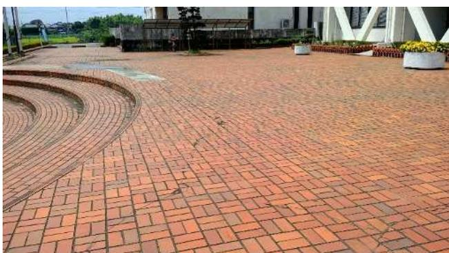
写真 17 外構タイル各所破損
