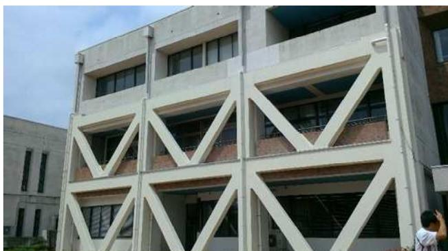
写真 15 耐震補強ブレース設置済
