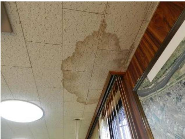
写真 13 開口部周りの天井雨漏り跡
