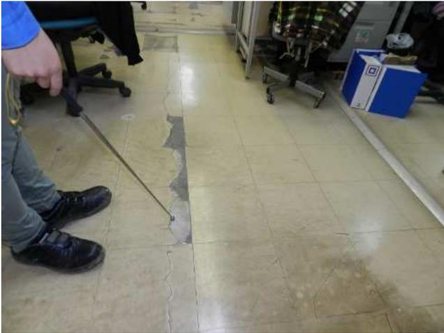
写真 11 執務室床の不陸・タイル破損
