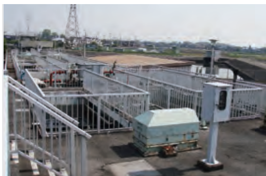
五霞町環境浄化センター
