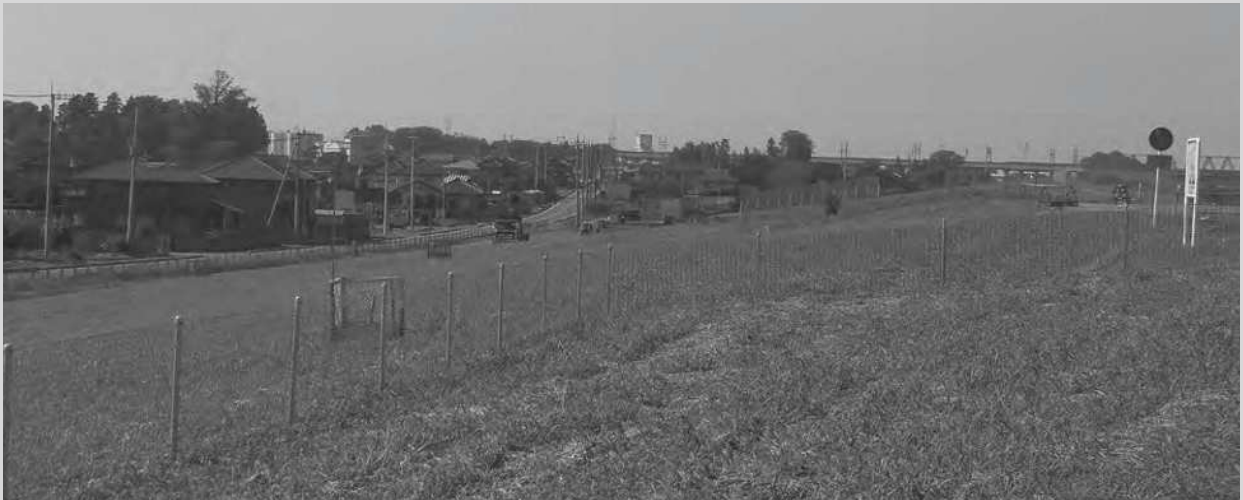
堤防の強化工事（川妻地先）
