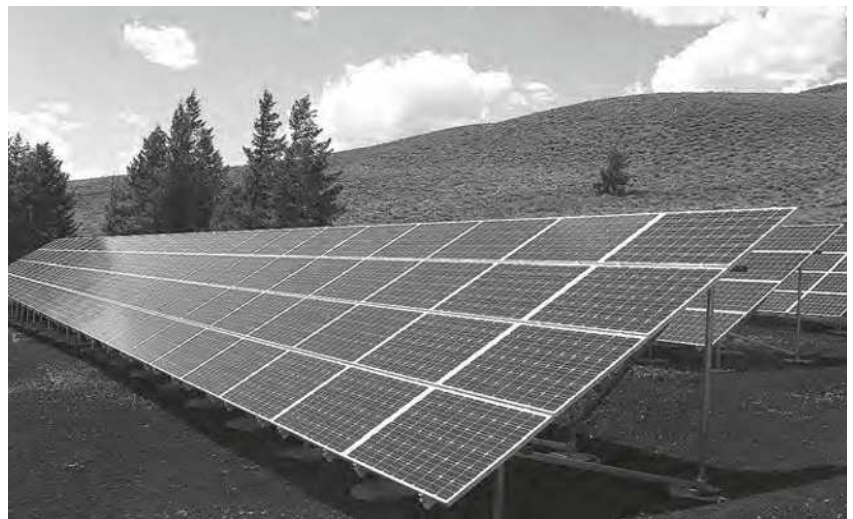
事業用太陽光発電設備設置例
