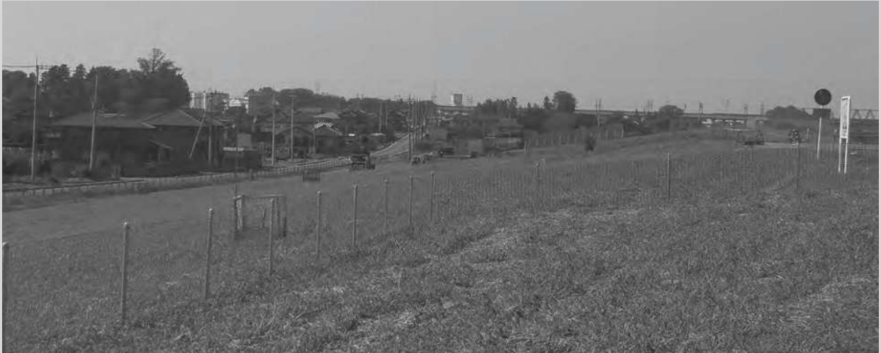
堤防の強化工事（川妻地先）
