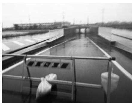
冠水により通行止めされた道路
