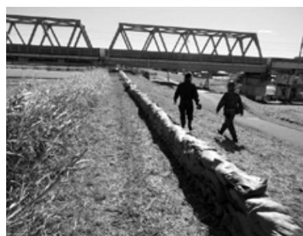
利根川の堤防に設置された土のう
