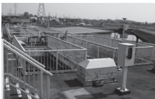
五霞町環境浄化センター
