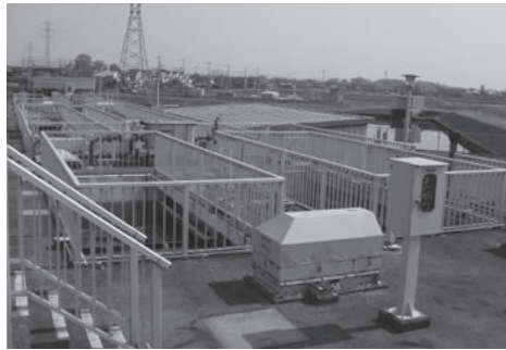
五霞町環境浄化センター
