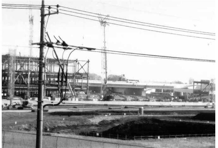
工事が進む進出企業
