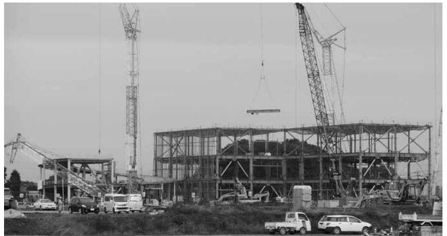
建築工事が進む物流施設
