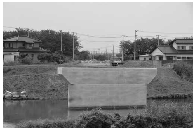
中川の新橋工事
