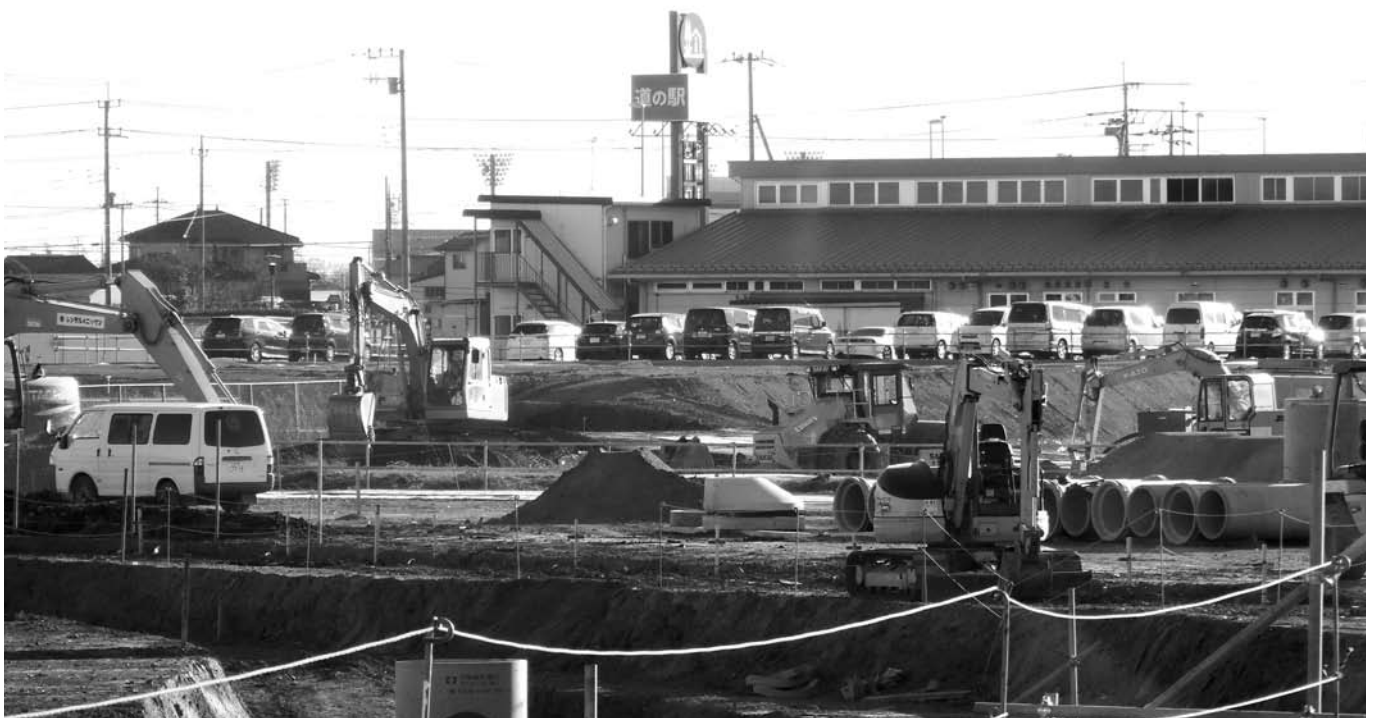
造成工事中の「道の駅ごか」東側
