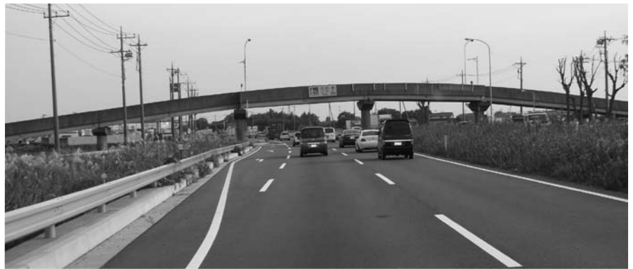
新4号国道から見た冬木橋
