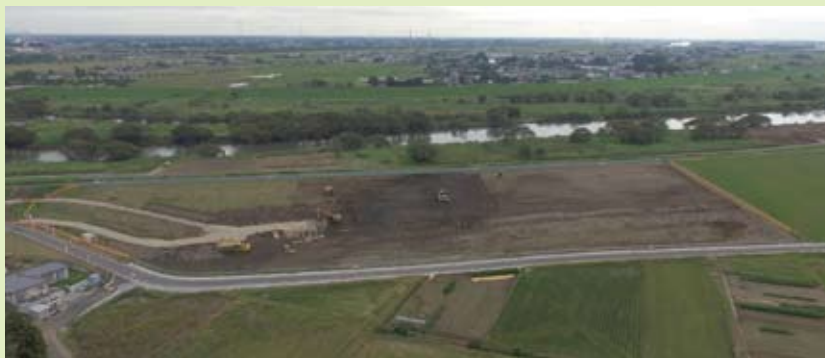
江戸川堤防工事(山王地先)
