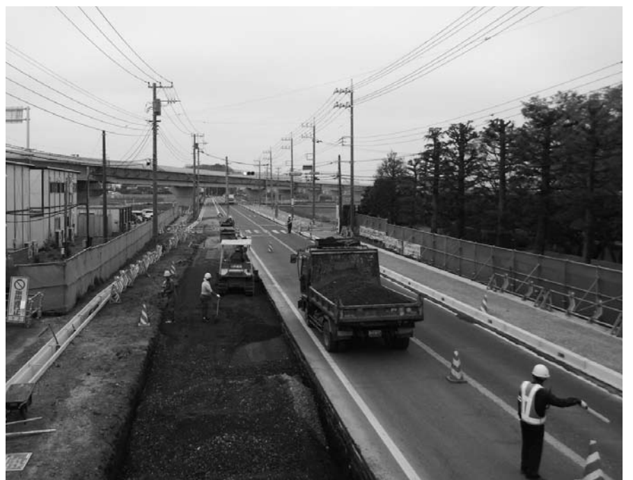
県道西関宿・栗橋線の工事風景
