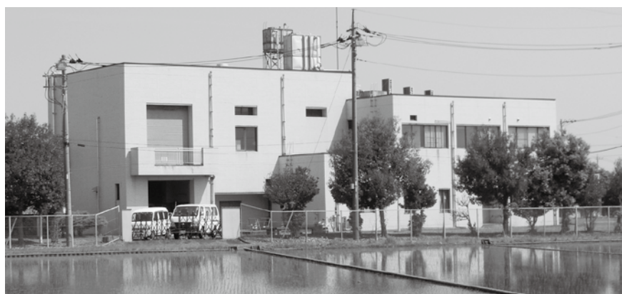
耐震工事をする環境浄化センター
