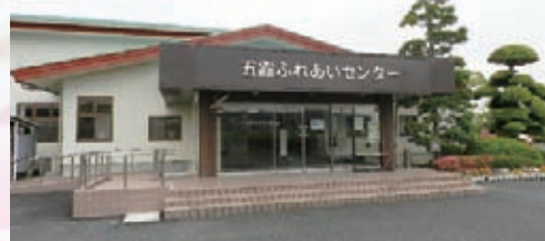
ふれあいセンターにおいて、空調の交換やバリアフリー化などの大規模修繕工事が行われました。(平成25年)
