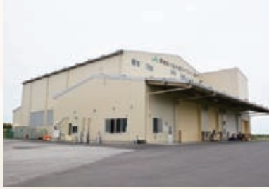
ライスセンターが完成しました。 (平成27年)
