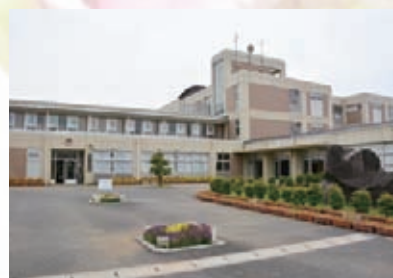
中学校耐震改築工事が行われました。(平成16年)
