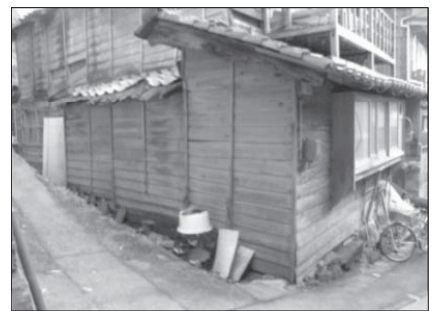
【福井県越前町】 老朽化した空き家住宅を撤却し、ポケットパークとして活用
