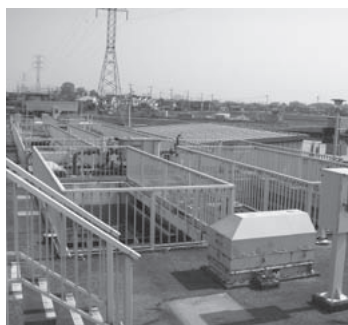
五霞町環境浄化センター
