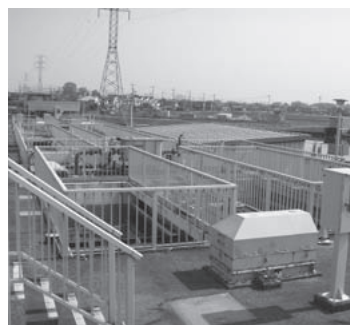
五霞町環境浄化センター
