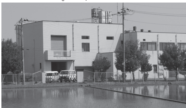
耐震工事をを行う環境浄化センター
