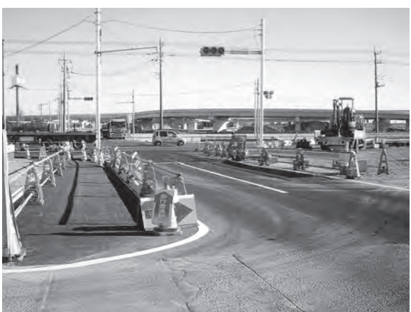
4車線化の道路改良工事（道の駅周辺）
