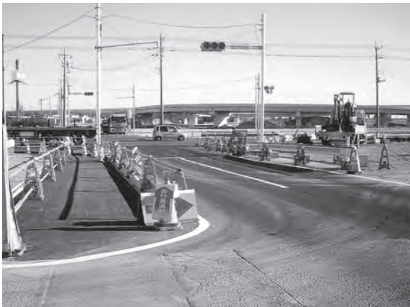
4車線化の道路改良工事（道の駅周辺）
