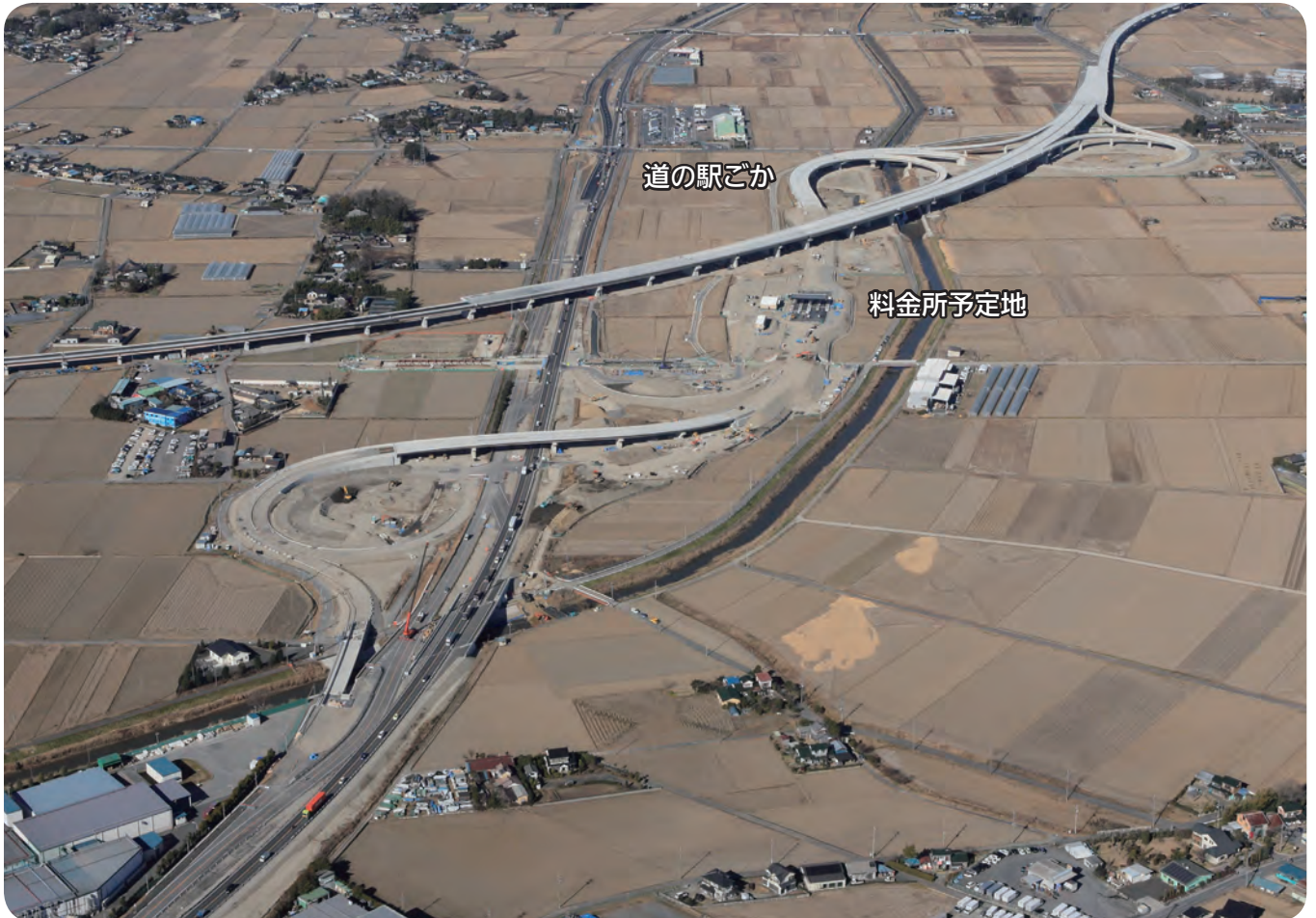
開通間近の圏央道五霞インターチェンジ
