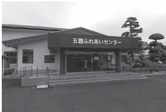
ふれあいセンター大規模修繕工事
