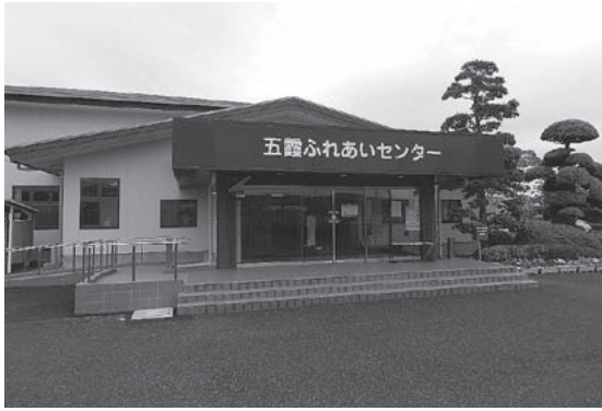
ふれあいセンター大規模修繕工事
