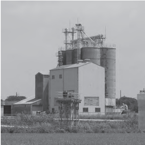
昭和48年竣工のカントリーエレベーター
