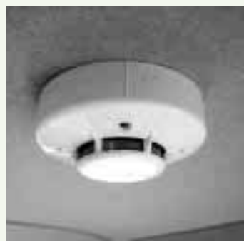
住宅用火災警報機（煙感知式）
