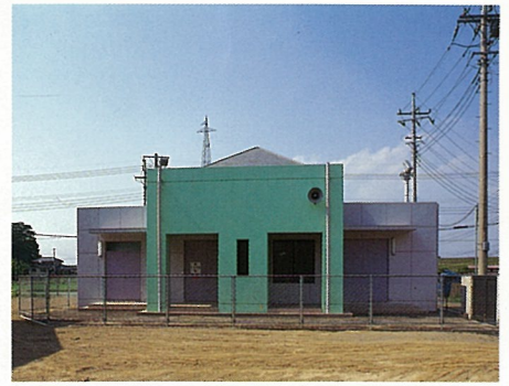
川妻取水場 原水は利根川右岸にある吸水槽から取水し、導入管により浄水場まで圧送される。
