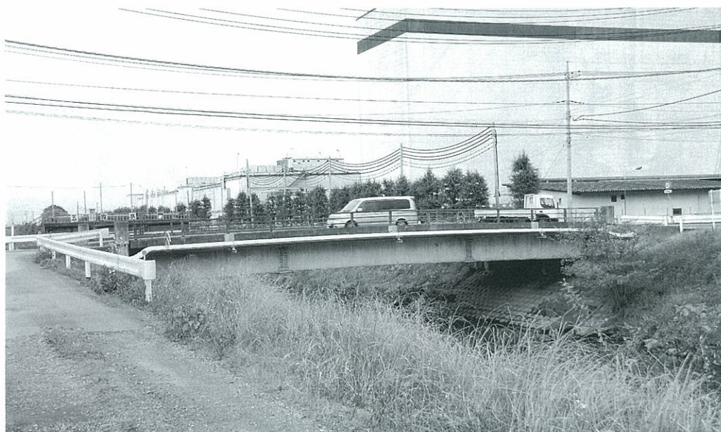
町道8号線にかかる川原橋（幸主地先）
