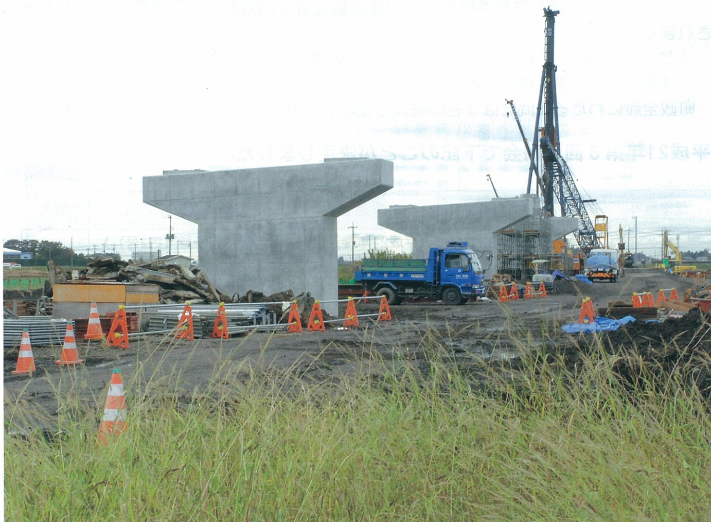
工事が進む圏央道（江川地先）
