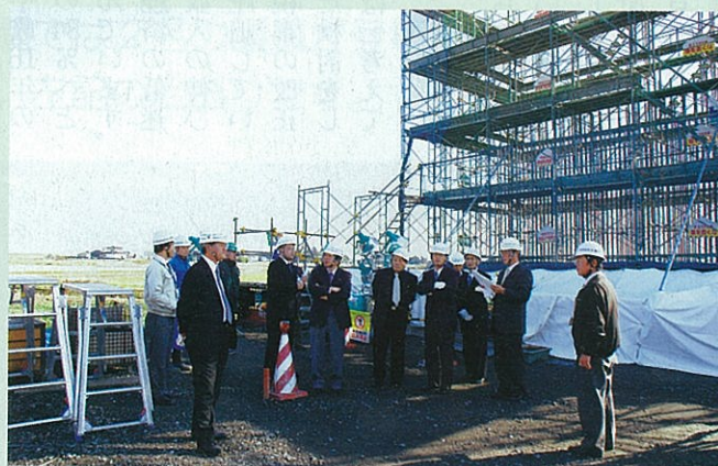
圏央道IC橋下部工事 (江川地内)
