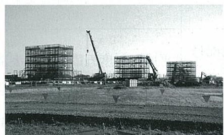
圏央道IC橋下部工事（江川地内）
